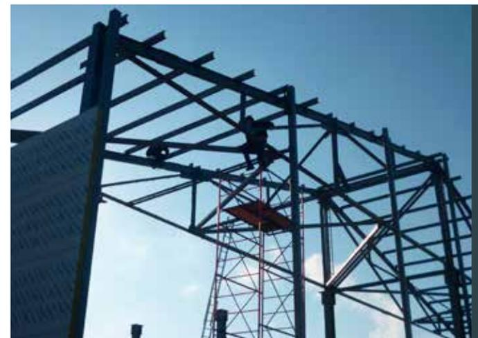
Одним из основных видов конструкций зданий являются каркасы несущие и дополнительные. Они воспринимают нагрузки снеговые и ветровые. Производственные мощности нашей компании позволяют реализовывать различные конструктивные варианты однопролетных зданий шириной 12,18,24,36,42,48,54 метров и более. Возможно укрупненная сборка и изготовление элементов каркаса на участке монтажа, что значительно снижает стоимость изготовления и транспортировки конструкций во время монтажа.
